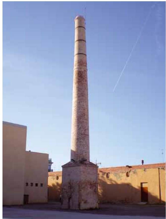
Chimenea de 80 palmos de altura
