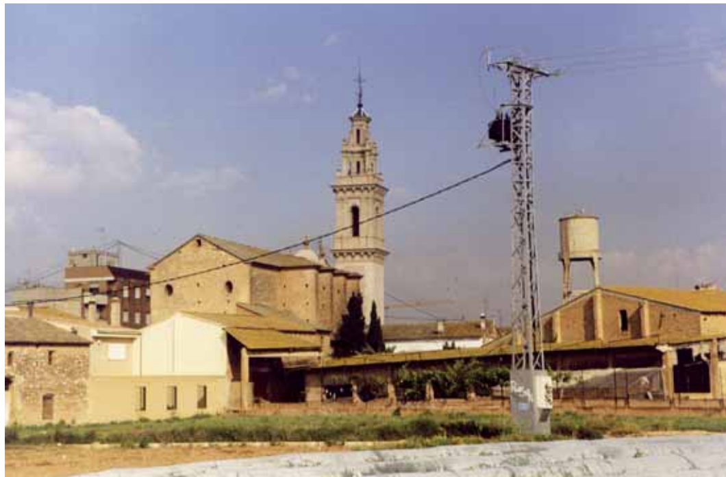
Transformador aéreo
