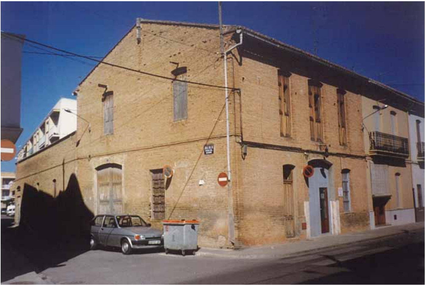
Vista lateral del almacén, antes de la expropiación para el ensanche de la calle del Socorro
