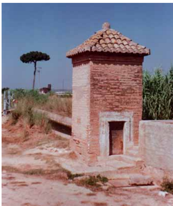
Partidor próximo a la Fábrica, donde se divide el caudal entre la acequia de Montcada y la Fila de Foios
