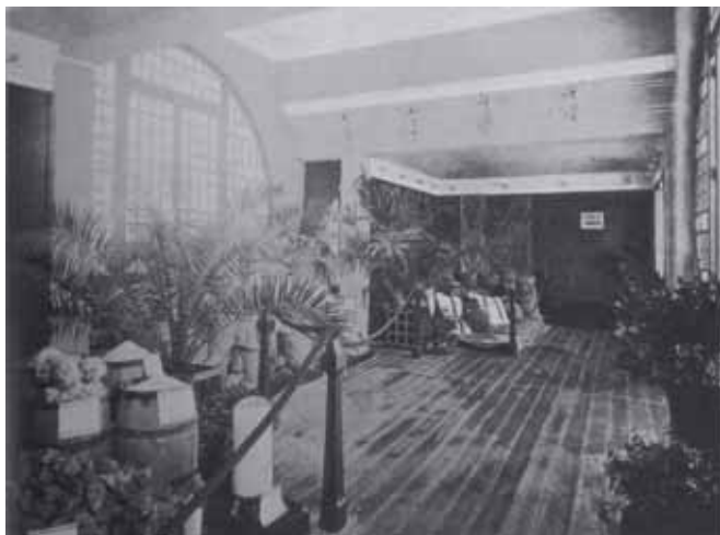
Pabellón de los Trenor. Exposición Regional de 1909. Vista exterior e interior
