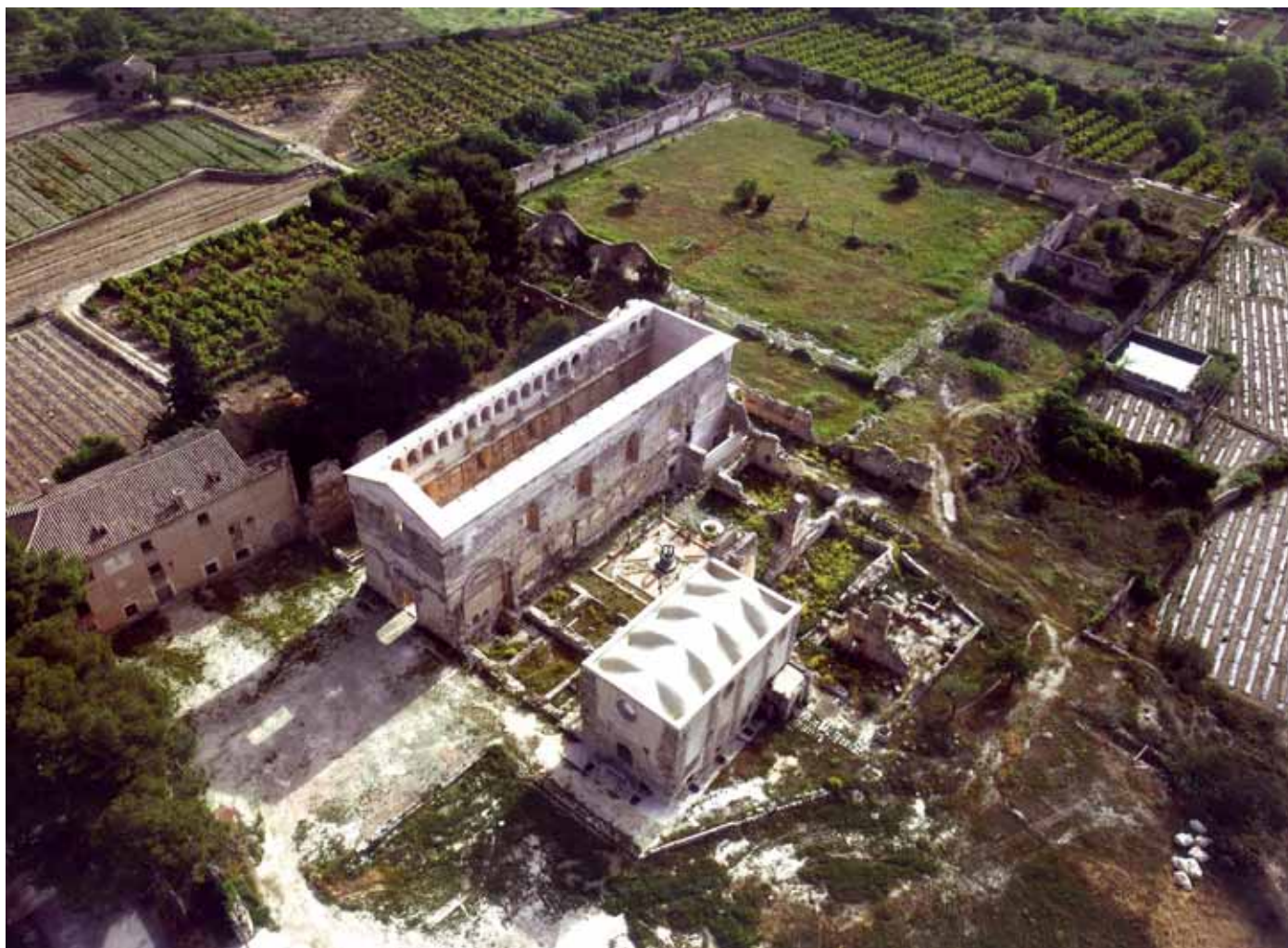
Vista actual de la restauración de las ruinas de la cartuja de Valldecris
