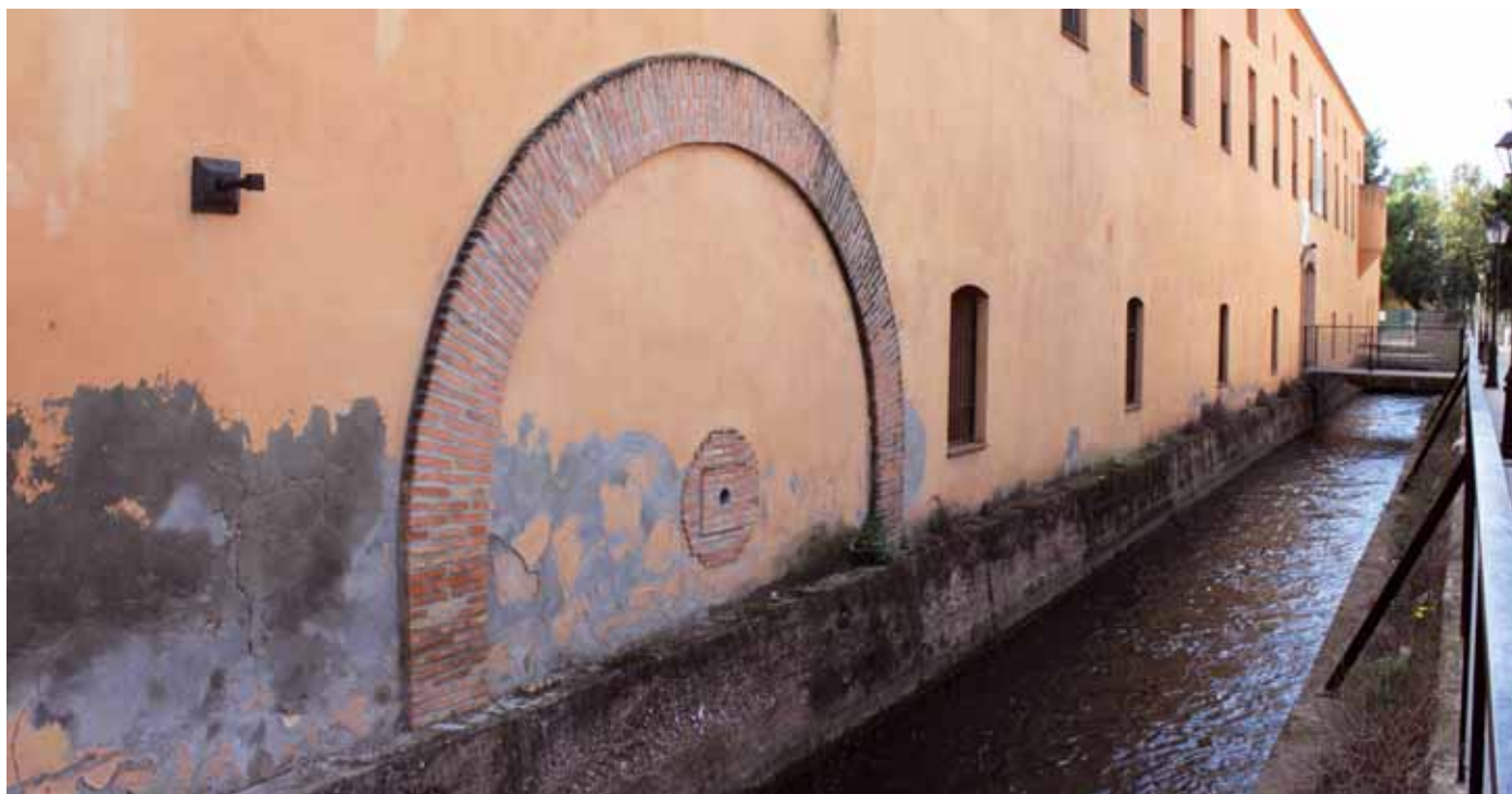
Vista lateral de la Fábrica, donde se puede apreciar el soporte lateral del eje de la rueda hidráulica
