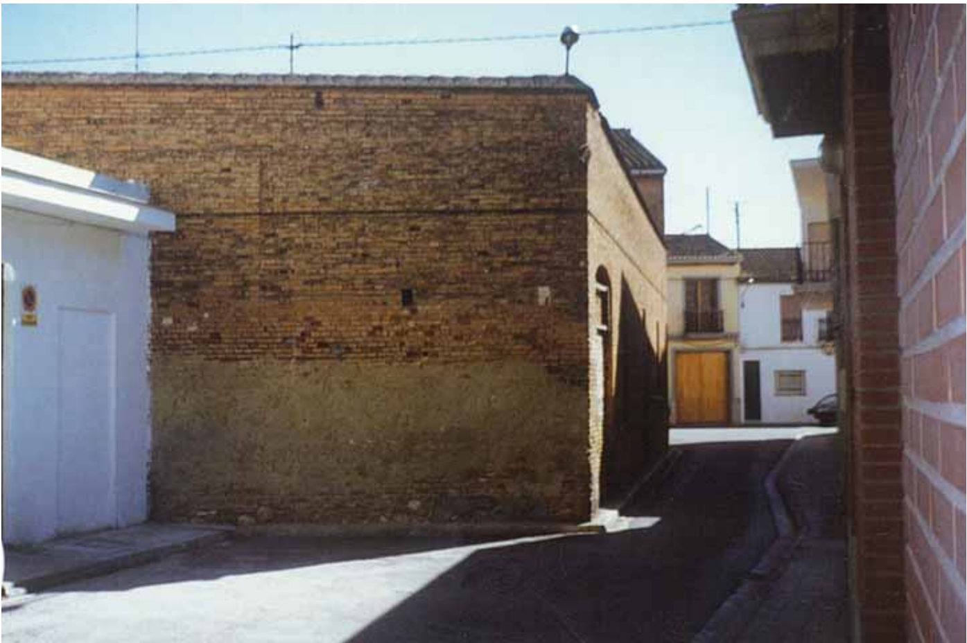
Vista del lateral del almacén donde se aprecia la zona expropiada en la calle del Socorro
