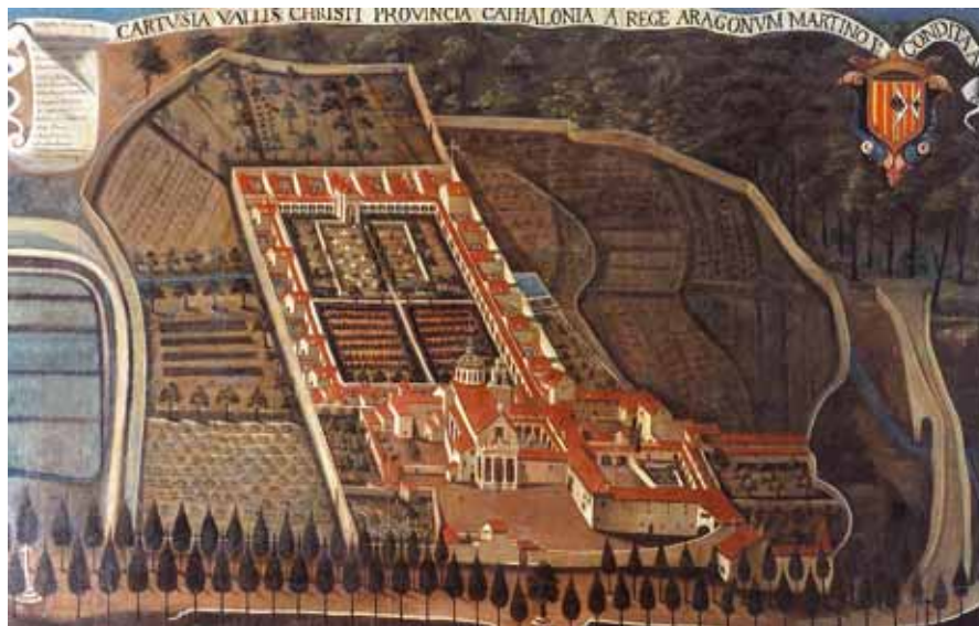
Cartuja de Valldecrist según la carte o pintura de la colección de la Grande Chartreuse. Cliché Musée Dauphinois. Grenoble. En la parte superior del lienzo, entre los dos cementerios, se puede apreciar la capilla de las Ánimas, lugar de enterramiento de doña Josepa Salvador, señora de Vinalesa
